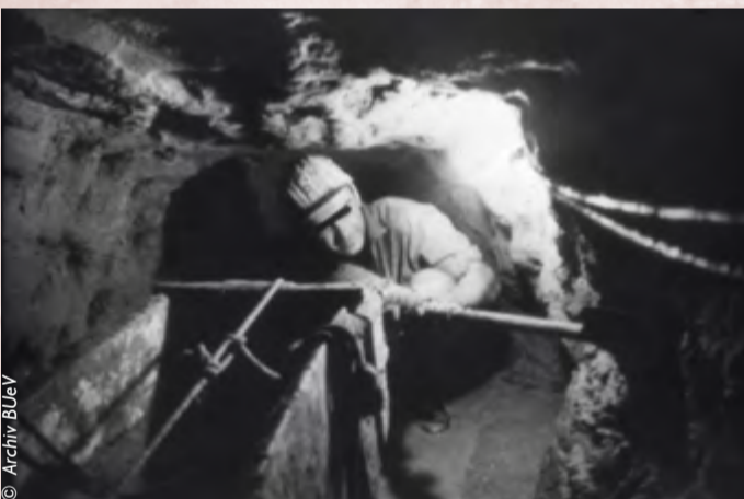
»Tunnel 57« im Bau, September 1964.
